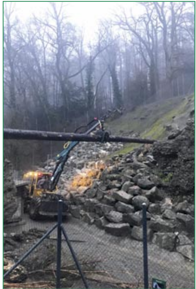
Neue Passerelle bei den Steinböcken
